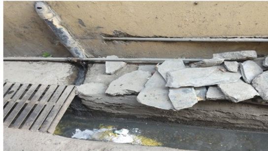
चम्बा में घरों से बरसाती पानी की नालियों में छोड़ी जा रही ग्रे-वाटर पाईप (06.04.2018)
